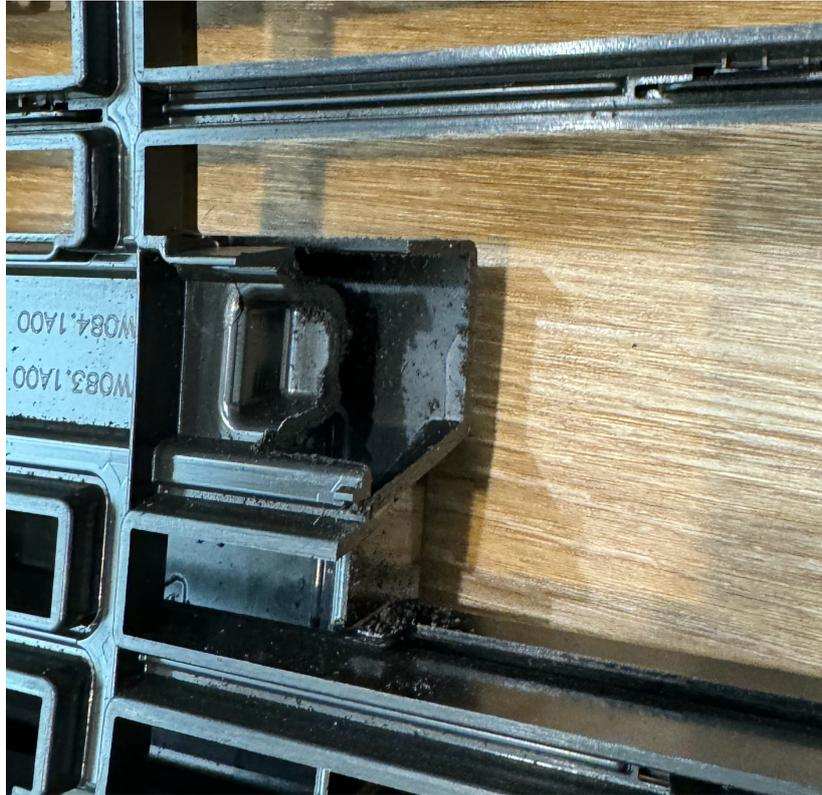
Die Kanten müssen sehr gut entgratet werden damit die Halter ohne Spannung aufgeschoben werden können. Die Halter müssen nicht verklebt werden.
